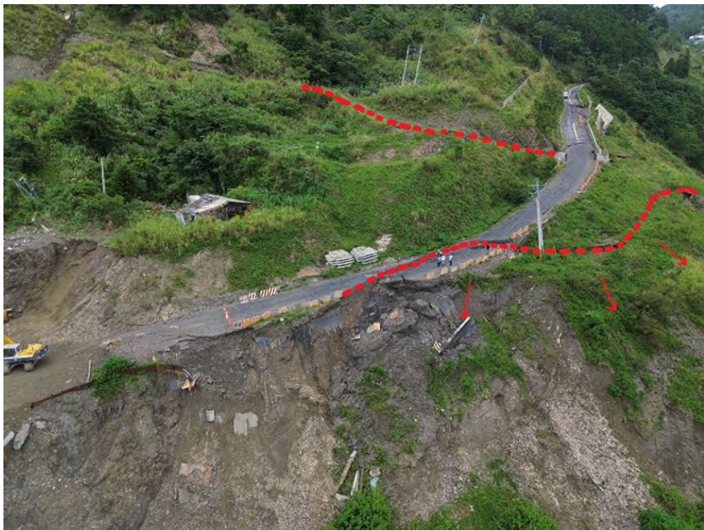
圖 4、紅色虛線為崩崖位置，紅色箭頭為邊坡滑移方向，(向東北拍攝；影像來源：國立成功大學防災研究中心，20250712)。
