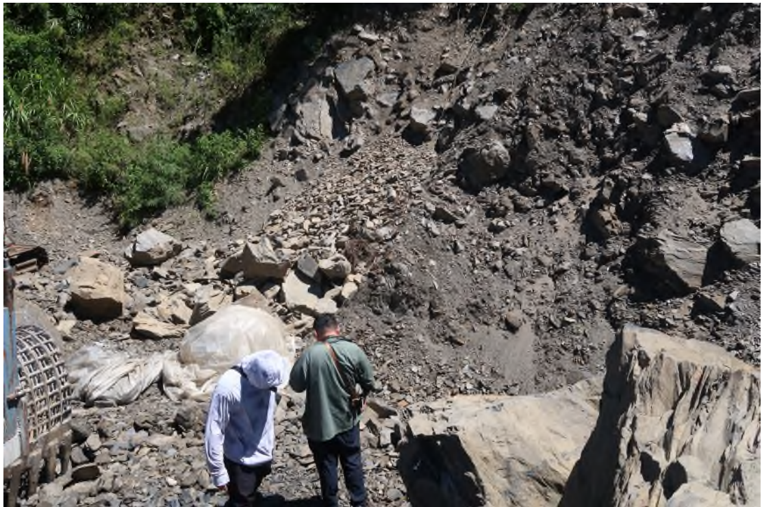
圖 17、靜觀大規模崩塌場址中一處人為開採砌石擋土牆所需岩塊，形成裸露崩積層(拍攝位置於圖 12-D 處)。
