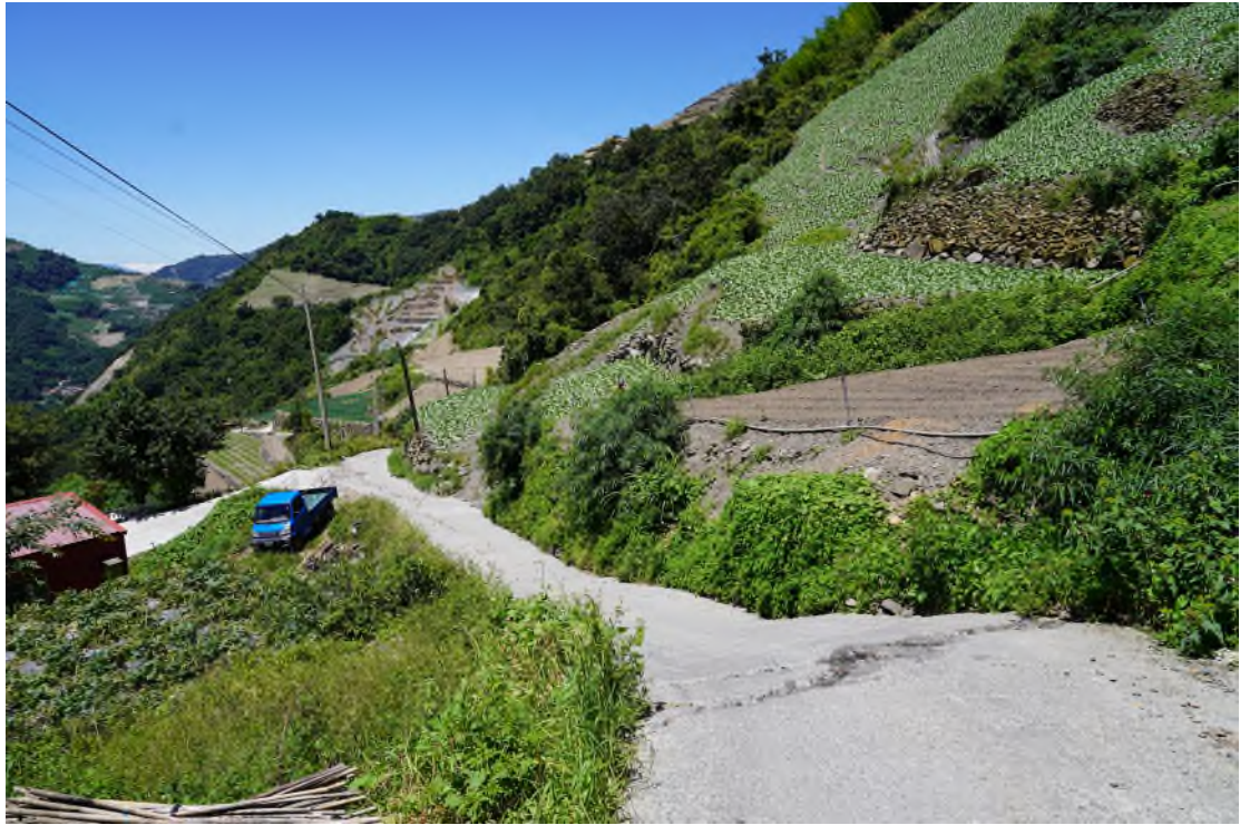
圖 16、靜觀場址坡中第 2 階次崩崖(拍攝位置於圖 12-G 處)。
