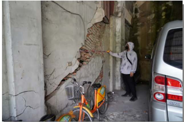
圖 8、圖 5-D 處受潛在大規模崩塌影響剪力破壞之結構物，左圖為 113 年 12 月 19 日拍攝、右圖拍攝日期 114 年 8 月 6 日(本次調查)，結構物裂隙未見擴大現象，本量測裂隙最大寬度為 1.5 公尺。
