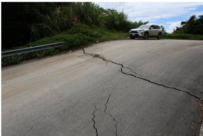
圖 10、廬山北坡滑動體的西側邊界、台 14 線 89.7 公里崩塌處。左圖為 112 年 8 月 11 日該崩塌處道路破壞情形，右圖為本次調查(114 年 8 月 6 日)拍攝，道路無明顯新增裂隙 (於圖 5-E 處拍攝)。
