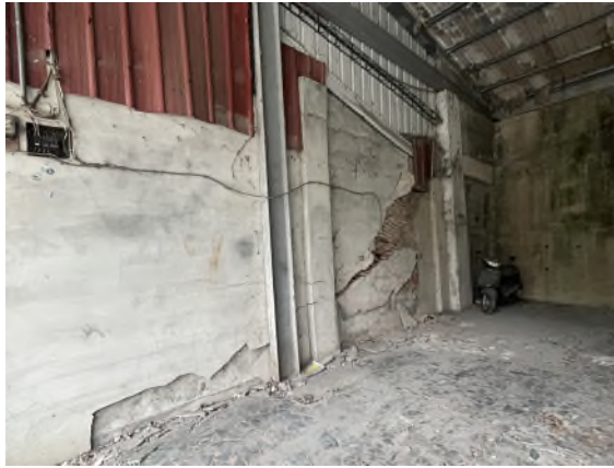
圖 8、圖 5-D 處受潛在大規模崩塌影響剪力破壞之結構物，左圖為 113 年 12 月 19 日拍攝、右圖拍攝日期 114 年 8 月 6 日(本次調查)，結構物裂隙未見擴大現象，本量測裂隙最大寬度為 1.5 公尺。
