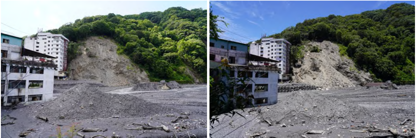
圖 6、緊臨飯店建築的廬山北坡東側坡趾新生崩塌，左圖為 112 年 6 月 10 日拍攝、右圖為本次調查(114 年 8 月 6 日)拍攝；可見表層崩積層向河道潛移，且趾部崖錐堆積範圍擴大。(於圖 5-A 處拍攝)
